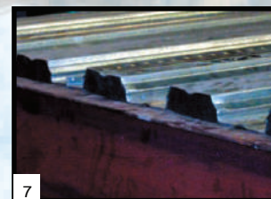
7 Pemasangan bila menggunakan endstop karet
