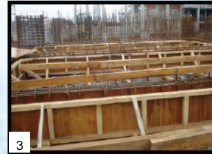
3 Letakkan Union New Floor Deck W-1000® di atas penyangga sementara
