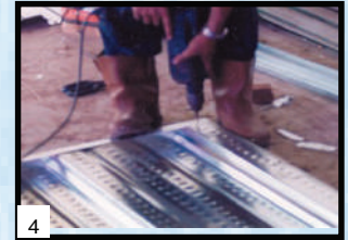
4 Endstop dipasang pada Union New Floor Deck W-1000®
