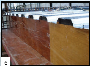
5 Kakukan Union New Floor Deck W-1000® dengan paku pada bekisting
