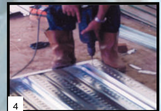
4 Endstop metal dipasang pada Union New Floor Deck W-1000®
