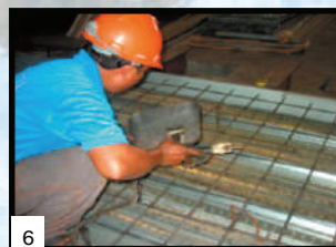
6 Kakukan Union New Floor Deck W-1000® pada bagian tepi dengan las titik di balok baja
