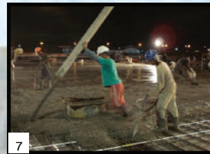
7 Penuangan beton
