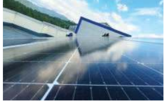
BCA Dormitory - Sentul
