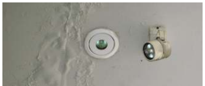
✗ Contoh: papan gypsum tidak tahan air
